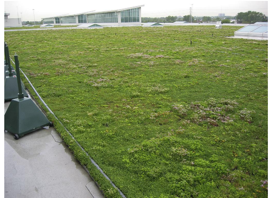
Toiture végétale sur le toit de la Ford Motor Company à Dearborn, Michigan; (Brad Rowe, 2010)
